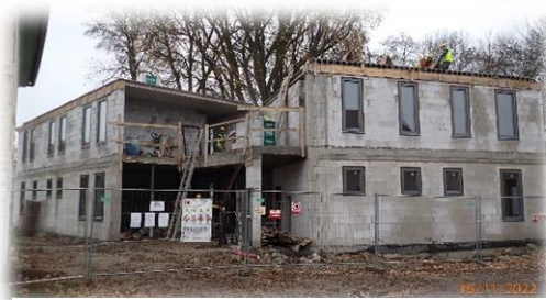
Výstavba nového azylového domu
